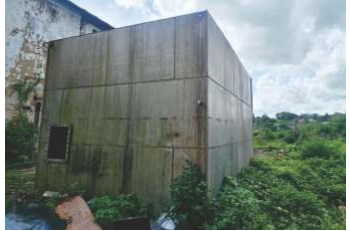
19 TANQUE INOX AISI 304 - 3.600 X 3.160 X 5.000 MM
